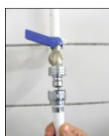
2. Schließen Sie den Schlauch mit dem Schlauchanschluß (0701) an den Wasserhahn.
